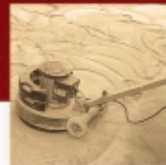
décapage des surfaces
