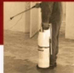
traitement de fond
